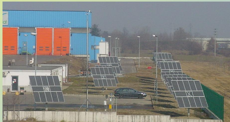
20 kW<sub>p</sub> a inseguimento solare (AMIAT)
